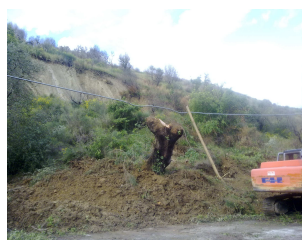
La frana sulla SP 94 in Contrada Fornace il 4 maggio
