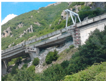
La carreggiata demolita
