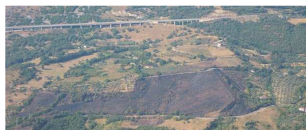
L'area del vasto incendio di c/da Tranciera
