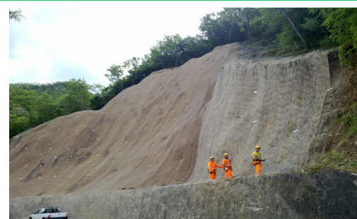
(Il lavoro concluso sulla Strada SP 94)
