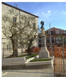
Lavori P.zza del Popolo
